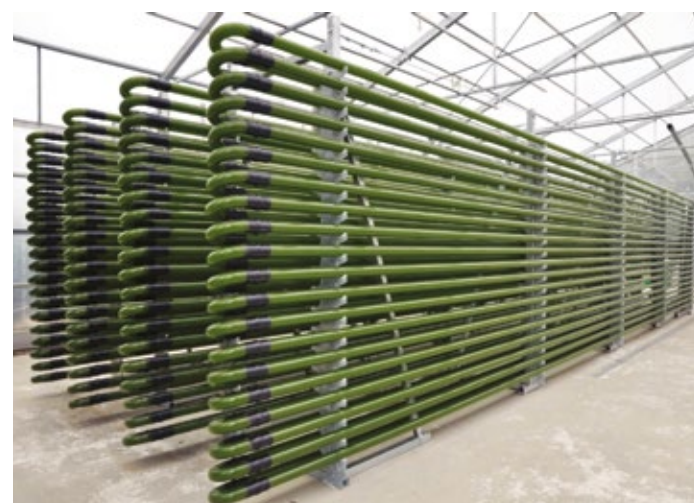
Фото 3.7. Фотобиореактор на водорослях из стеклянных прозрачных труб.
